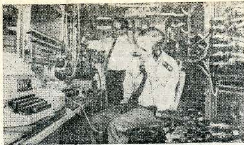
Рис. 2. Аппаратура районного центра коммутации, установленная в контейнере автомобиля
